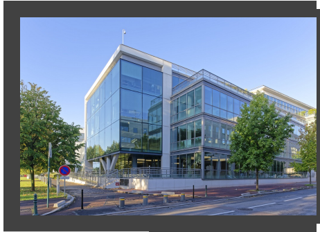
Immeuble Airbus - 5, quai Marcel Dassault à Suresnes (92) © DR
